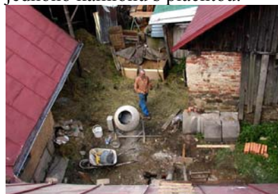
Pohled od komína na dvůr. Seno se začíná vršit v levém horním rohu.
