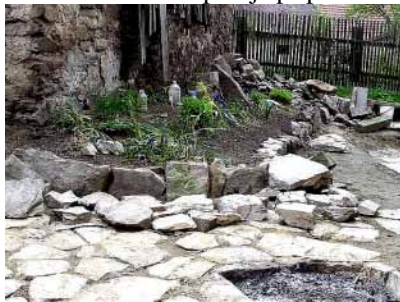
Dlaždičské a zahrádkářské práce před dokončením.
